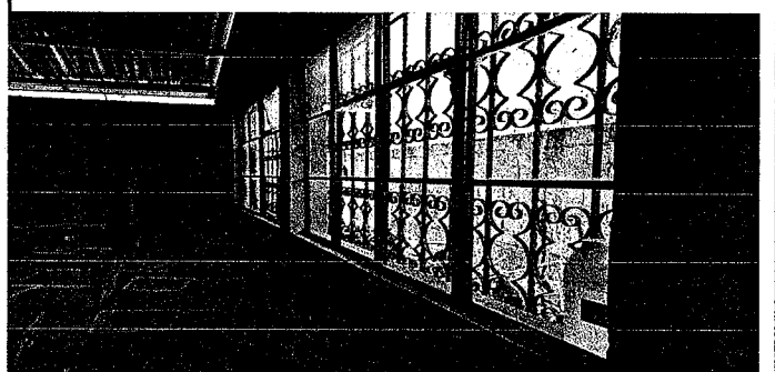
SUSTITUCION DE VENTANALES
